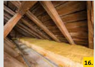
**16.** Nach den anfänglich aufwendigeren Anpassarbeiten der ersten Bahn gehts schneller: Alle weiteren Dämmstoffbahnen werden nur noch fugendicht daran gestoßen.
