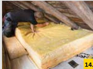
**14.** Zuerst den Filz vor die Traufkonstruktion schieben und die Ausschnitte für die Sparren mit dem Messer markieren. Dann jeden Sparren ausklinken.
