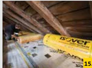
**15.** Filz mit den Ausklinkungen bis ans Stellbrett an der Traufe schieben. Bei Bedarf Lücken mit loser Wolle stopfen.
