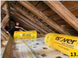
**13.** Sobald die Abdichtungsarbeiten fertiggestellt sind, folgt die Dämmung mit Topdec DF 1-035 RENO.
