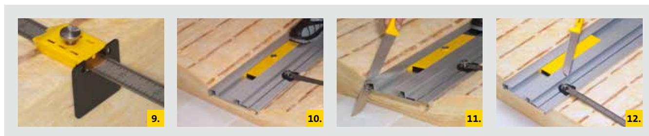
**9.** Integra FastCut auf dem Filz ausrichten. Dann die Schneideunterlage passend unter dem Dämmstoff positionieren.
