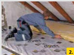
**2.** An einer Wand beginnen und Bahn an Bahn dicht gestoßen verlegen.
