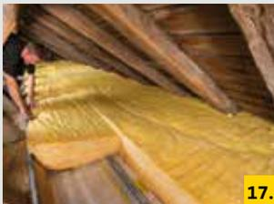
**17.** An allen aufgehenden Bauteilen sind die Filze so anzuschneiden, dass keine Hohlräume verbleiben.
