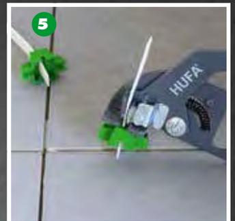
**5** Nachdem der Fliesenkleber ausgehärtet ist, müssen Sie mit der Nivellierzange die Zugkappen überspannen. Die Zuglaschen reißen dann an der dafür vorgesehenen Sollbruchstelle, nur dadurch ist eine ordnungsgemäße Verarbeitung gewährleistet. Für unsachgemäße Anwendung können wir keine Haftung übernehmen.
