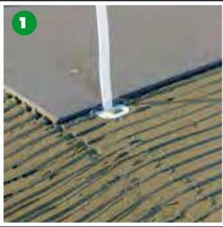
**1** Legen Sie die erste Fliese (mind. 5 mm Fliesendicke) in den Kleber und schieben Sie die Zuglasche unter die Fliese. Die Zuglasche sollte für beste Ergebnisse ca. 10 cm von der Ecke entfernt sitzen. Positionieren Sie an jeder Ecke, ca. 10cm entfernt, eine Zuglasche.
