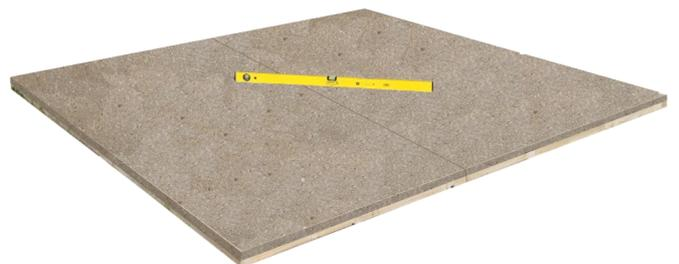
Fußbodenelemente von unten behandeln, zusammenlegen, umdrehen und mit einer Wasserwa-
