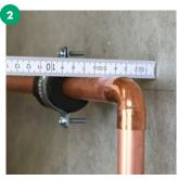
Abstand zwischen Rohrleitung und Wand messen um die bestmögliche Wandstärke der Dämmung zu ermitteln. Beispiel: Ein Wandabstand von 20 mm erlaubt keine Dämmung mit einer Wandstärke von 25 mm.
