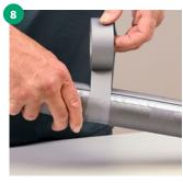
Querstöße sind fugenfrei mit dem CLIMATUBE® PVC Klebeband zu sichern. Das Band überlappend in 2-3 Lagen anbringen und dabei fest andrücken. Alle Oberflächen müssen trocken, staub- und fettfrei sein
