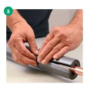
Den Zip-Verschluss anschließend wieder der Länge nach verschließen.
