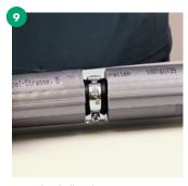
Bei Rohrschellen die Dämmung an beiden Seiten bündig anbringen.
