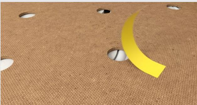
Auflegen der Schablone im geplanten Bereich der fermacell® Gipsfaserplatte als Abdeckplatte. Kontrolle, ob sich Heizrohre im Befestigungsbereich befinden. Falls ja, Befestigungspunkt mit Klebeband abdecken.
