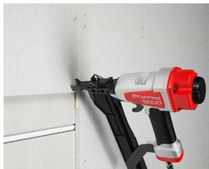
Befestigung zusätzliche Lage fermacell® Gipsfaserplatte oder Powerpanel H<sub>2</sub>O inkl. Fugenausbildung
