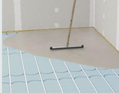
Ausgießen der Therm25™ Elemente mit fermacell™ Ansetzbinder
