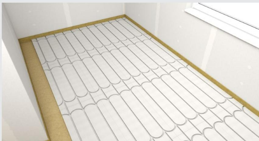
Nach der Verlegung der Fußbodenheizrohre sind diese unter Wasserdruck zu stellen, damit die Dichtheit des Fußbodenheizsystems kontrolliert werden kann. Danach kann die Verlegung der zusätzlichen fermacell® Gipsfaserplatte (Dicke gemäß Anwendungsbereich) geschehen. Diese Lage wird im schleppenden Verband mit einem Fugenversatz von > 167 mm zu
