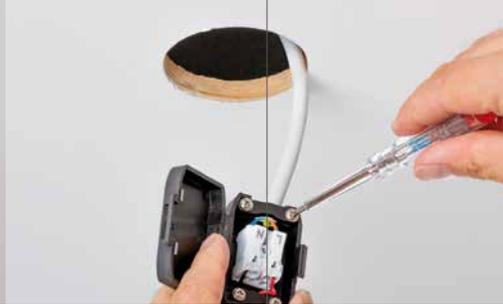
Einfacher Anschluss an der Schnellklemme
