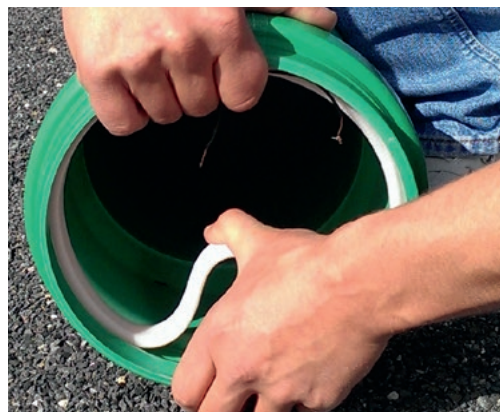
Einlegen des Schweißringes.
