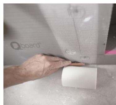
**4.** Abschließend müssen Sie alle Bauplattenstöße mit dem selbstklebenden Qboard® Armierband abkleben und mit Fliesenkleber aufspachteln. Für den Nassbereich (z.B. Dusche) verwenden Sie das Qboard® Abdichtungsset 2-k.
