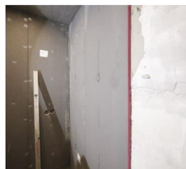
**2.** Bringen Sie die Qboard® basisq Bauplatte so an die Wand, dass Sie einen ebenen, lot- und fluchtgerechten Untergrund für die Weiterbearbeitung erhalten.
