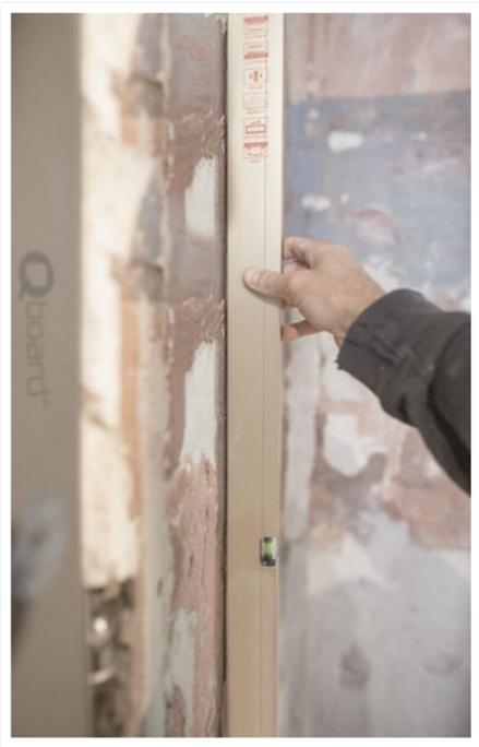
Mit Qboard® basiq schaffen Sie saubere und ebene Wandflächen, dämmen zusätzlich den Raum und schützen so das Mauerwerk dauerhaft vor Feuchtigkeit. Die mörtelbeschichtete Oberfläche bildet einen ideal haftenden Untergrund und kann direkt verflies, verspachtelt oder verputzt werden.
