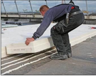
Bild 1: Verlegung von PU Dämmplatten
