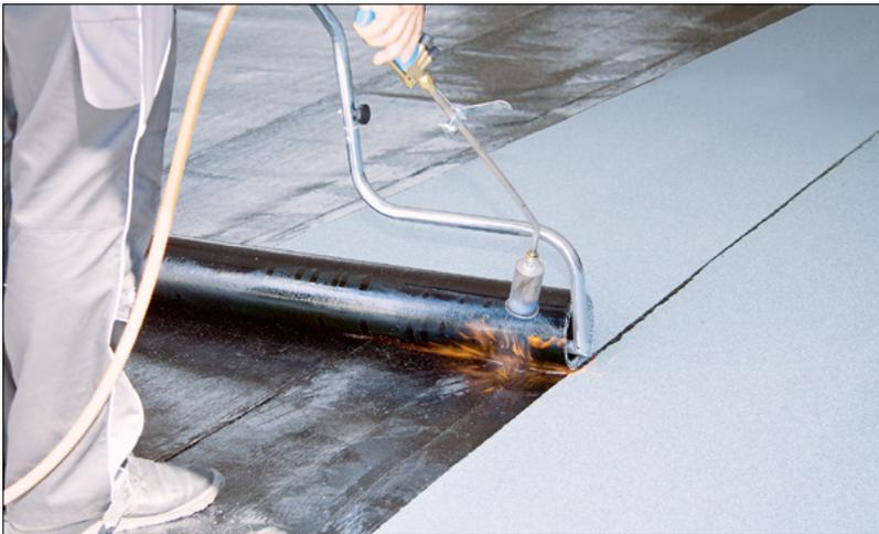
Bild 6: Verarbeitung im Schweißverfahren mit Rollenführungsbügel
