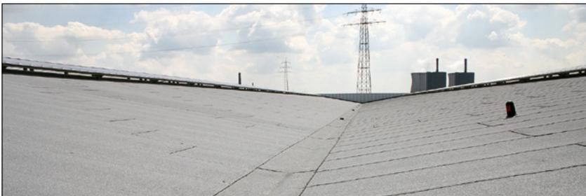
Bild 4: Abdichtung eines Industriedaches mit Polymerbitumenbahnen
