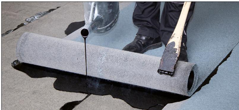
Bild 11: Verarbeitung einer Bitumenbahn im Gieß- und Einrollverfahren
