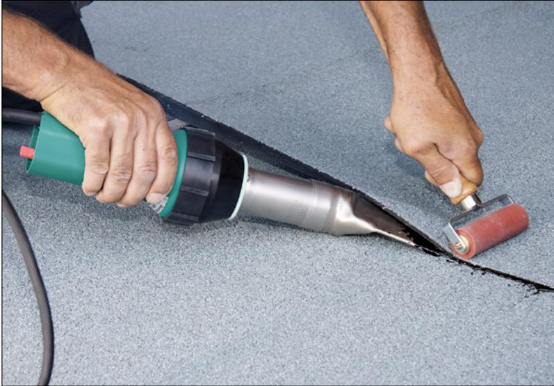
Bild 9: Fügen der Quernähte mit Heißluftfön und Andruckrolle
