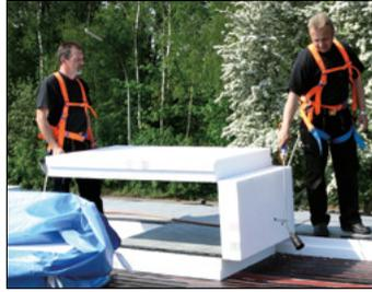
Bild 2: Verlegung einer kaschierten Dämmbahn
