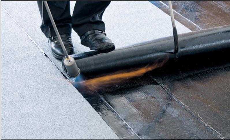
Bild 5: Aufbringen einer beschieferten Oberlagsbahn im Schweißverfahren
