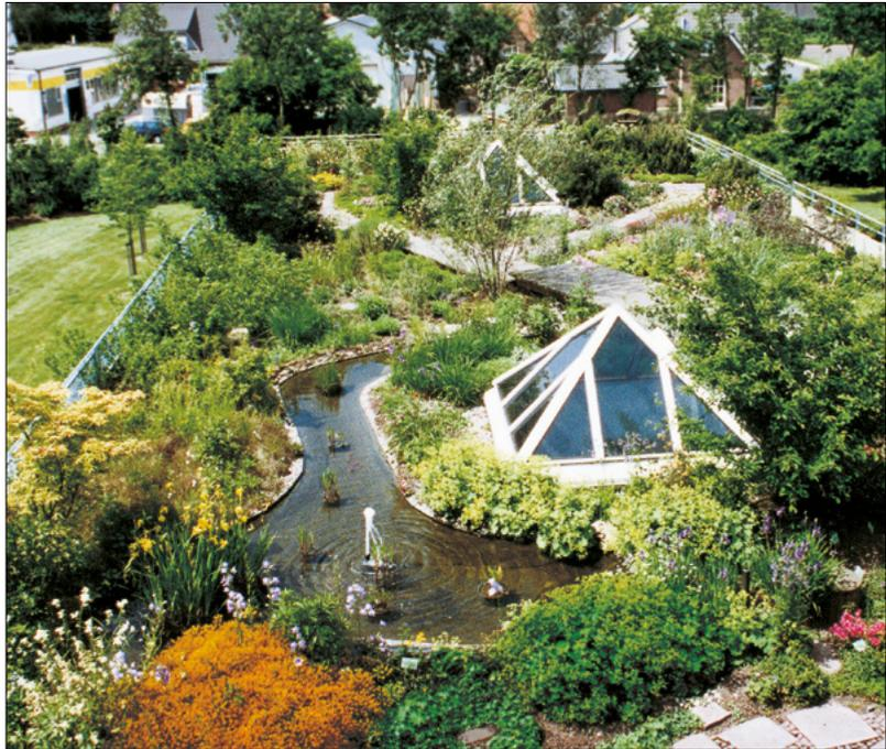
Bild 12: Beispiel einer intensiven Dachbegrünung
