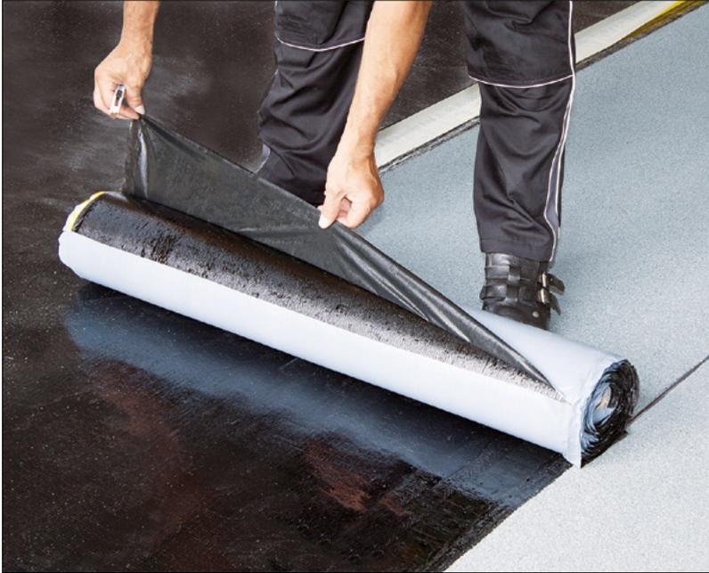
Bild 7: Verarbeitung von kaltselfstklebenden Polymerbitumenbahnen
