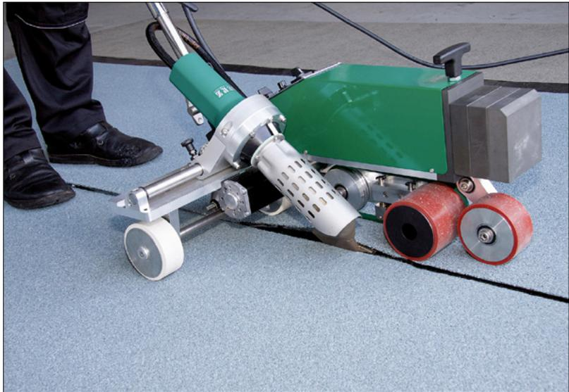
Bild 8: Schließen der Längsnähte mit dem Heißluftautomaten
