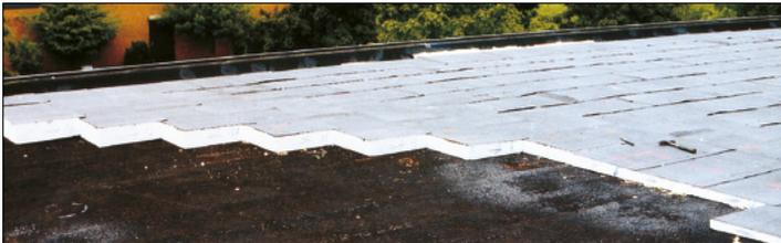
Bild 3: Beispiel einer Gefälledämmung aus Gefälledämmplatten
