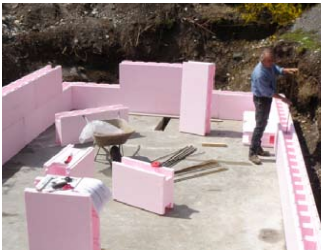
Einsetzen der Steckeisen und betonieren der ersten Reihe
