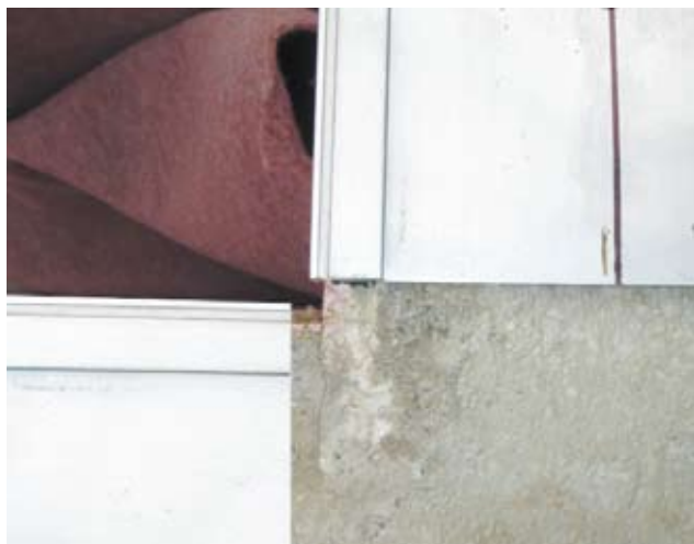
Montage des Einhängeprofils und Vliesmontage
