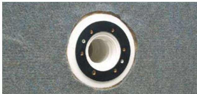
Düse ohne und mit Gummidichtung
